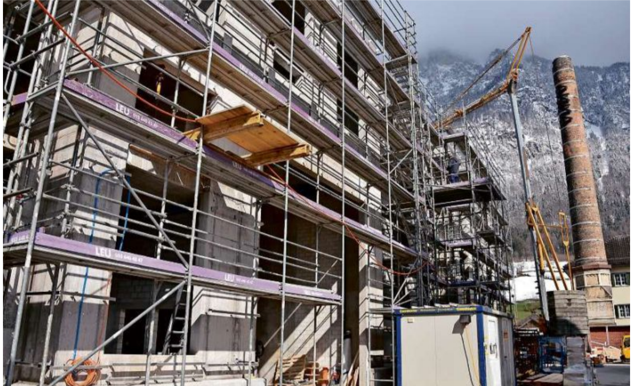
Ein Zeichen für die Zukunft: Der Rohbau des Werks II steht und ist bereit für den Innenausbau.
