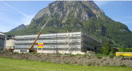
Bau des Zuschneidecenters
