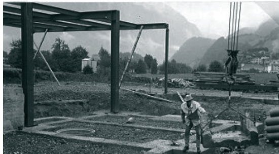
Hans Eberle beim Bau der Spenglerei
