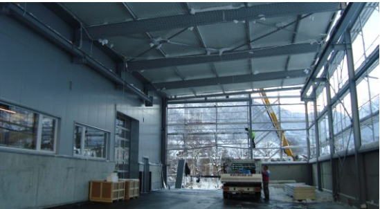
Die Blecheinlagerstation wird überdacht
